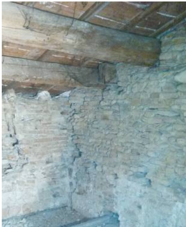
Dettaglio fessurazione controvento murario
