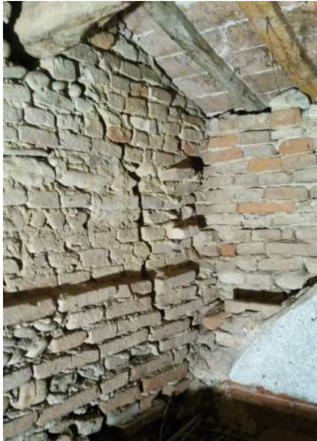
Dettaglio fessurazione controvento murario
