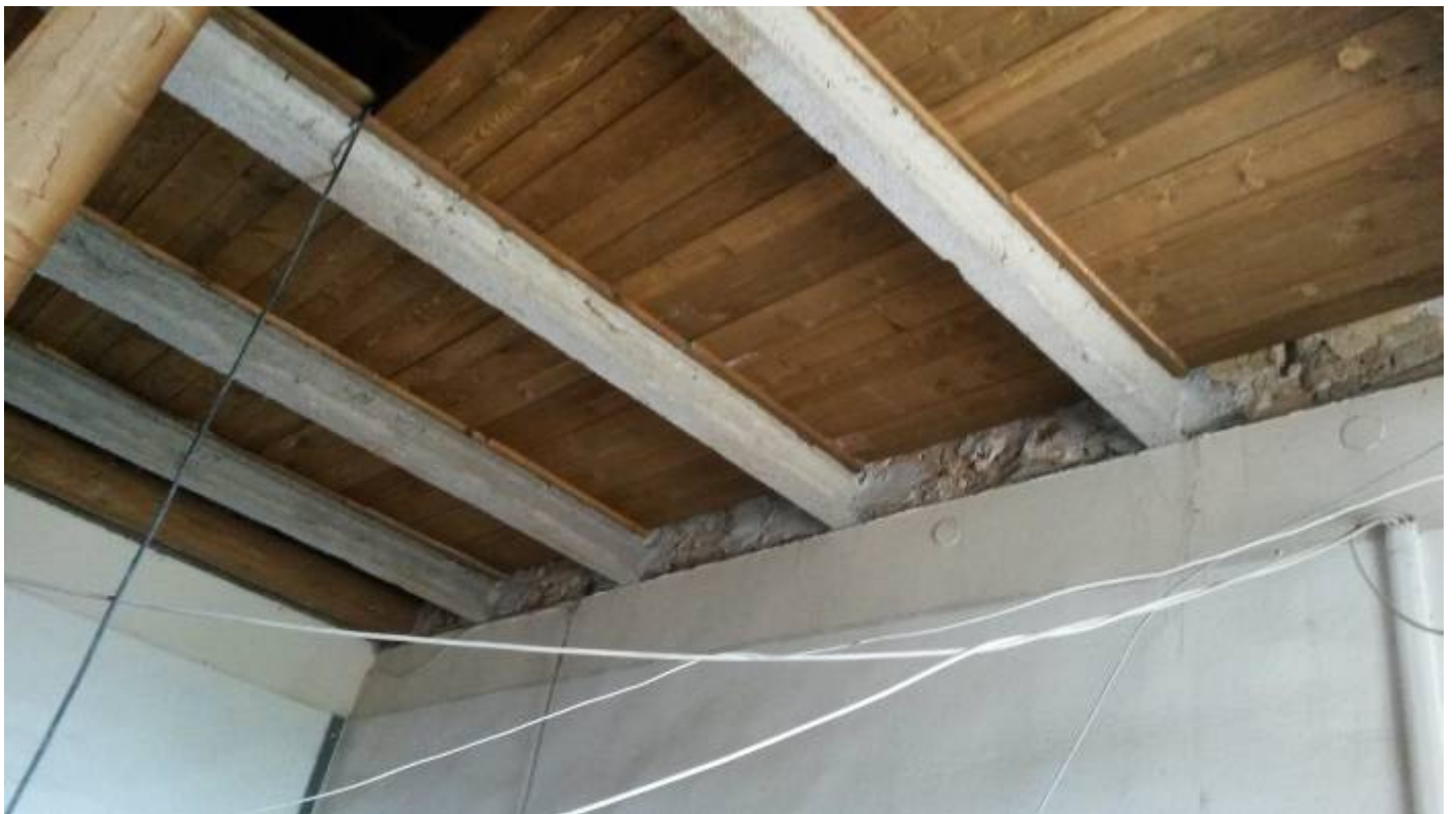
Dettaglio intradossale controsoffitto di sottotetto
